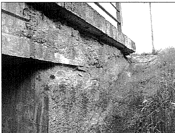
Poruchy na bočním líci objektu
